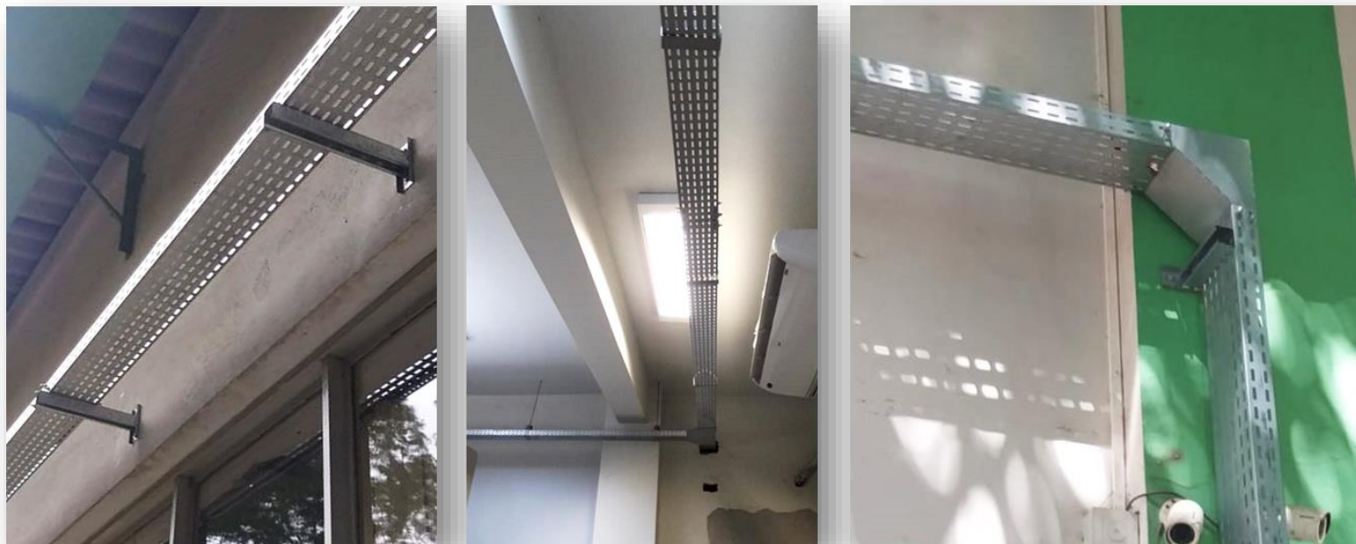
Figura 3 - Instalação de calhas para rede elétrica dos Ares Condicionados.
