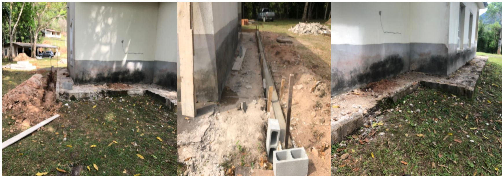
Figura 7 - Manutenção Elétrica e Predial REBIO
