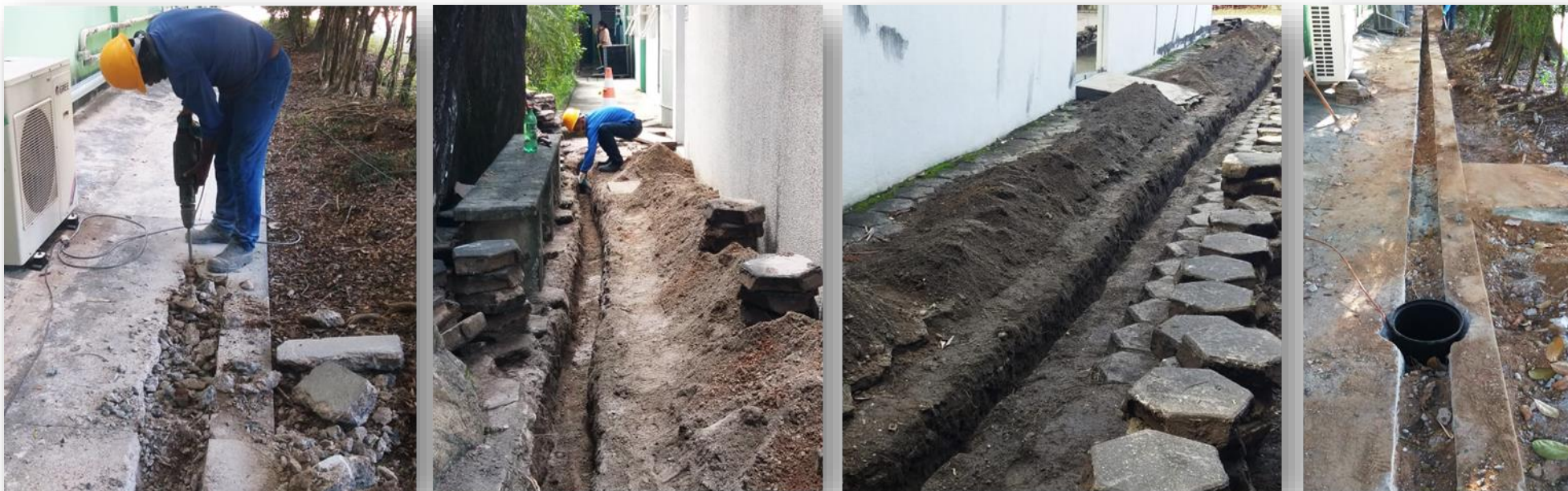
Figura 2 - Execução de aterramento do Prédio 1.
