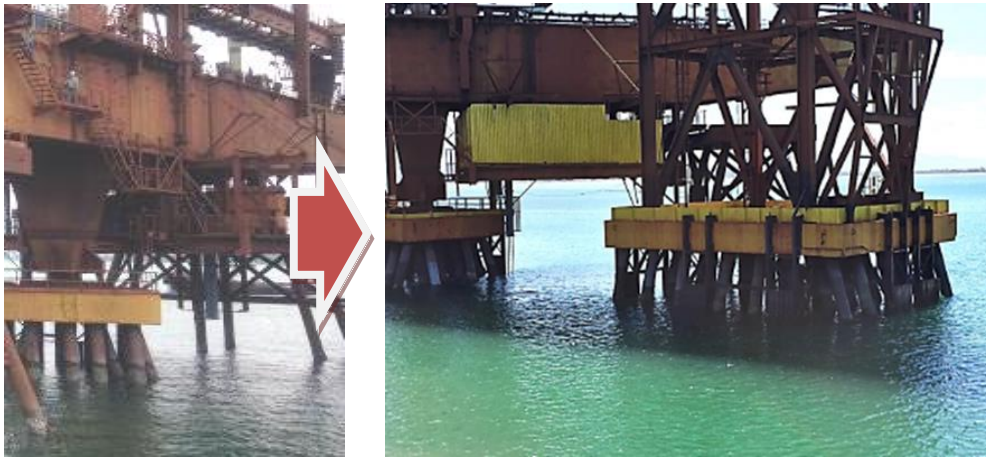
Enclausuramento do acionamento das correias dos CNs do Píer 2.
