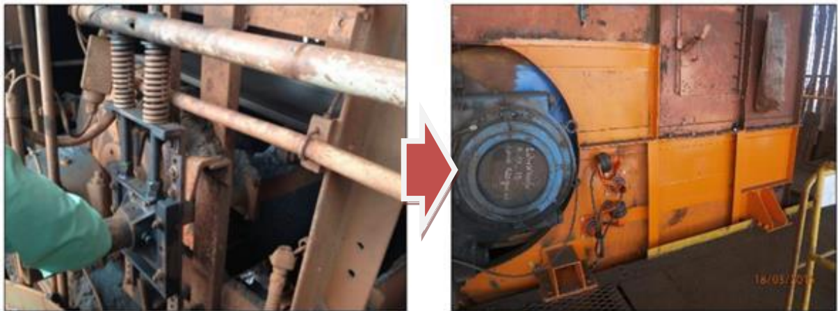
Fechamento de aberturas (laranja), substituição e instalação de raspadores pneumáticos no transportador D15.
