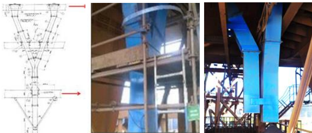
Projeto, obra e finalização da calha do CN4.
