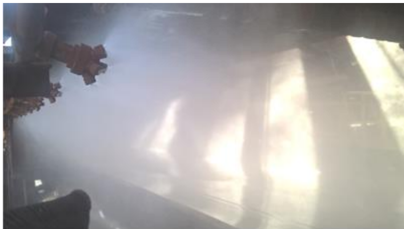
Aspersores de névoa no transportador em operação.
