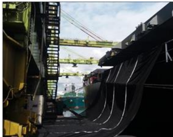
Exemplo de instalação de mantas entre navio e píer para contenção de material.
