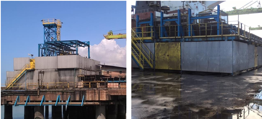
Enclausuramentos realizados no píer de carvão.
