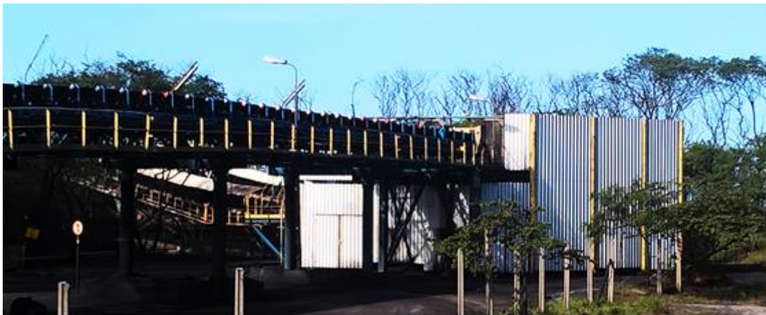
A transferência da rota TC17 foi enclausurada com material rígido.
