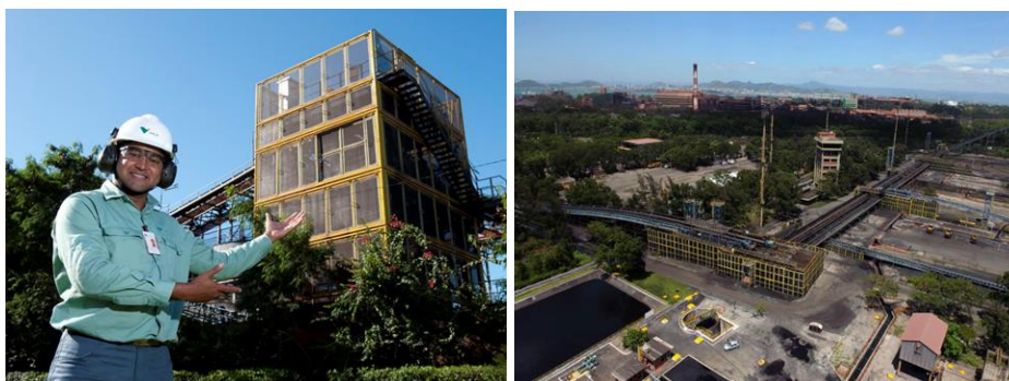
Enclausuramento de Correias Transportadoras
