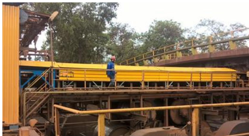
Enclausuramento complementar de D13 ( pier 2) até o acionamento.
