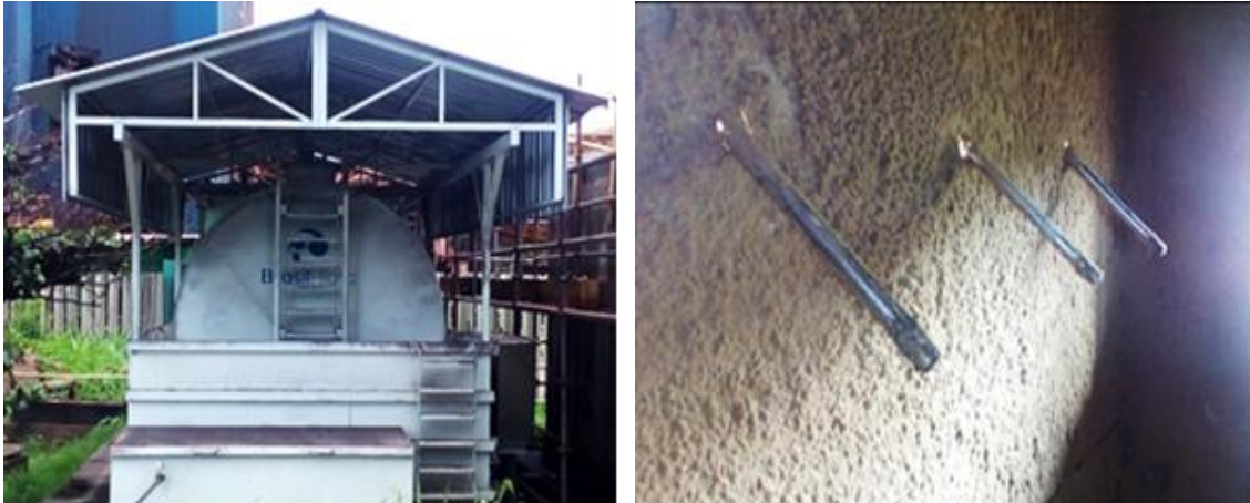
Tanque de armazenamento do óleo vegetal e bicos aspersores.
