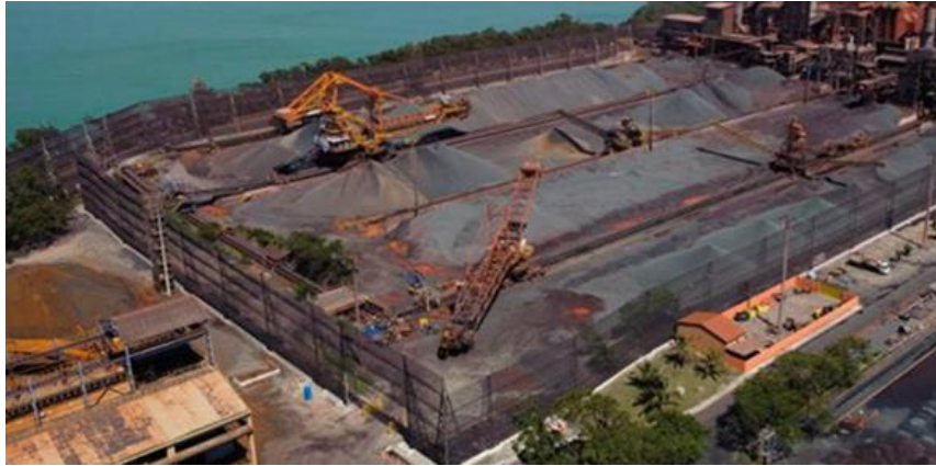
Primeira wind fence instalada no Complexo de Tubarão – Pátio das Usinas de I a IV – agosto de 2009
