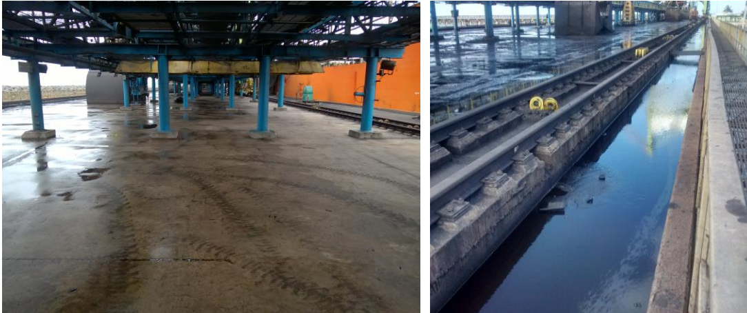
Pier após lavagem com direcionamento do efluente para a canaleta.
