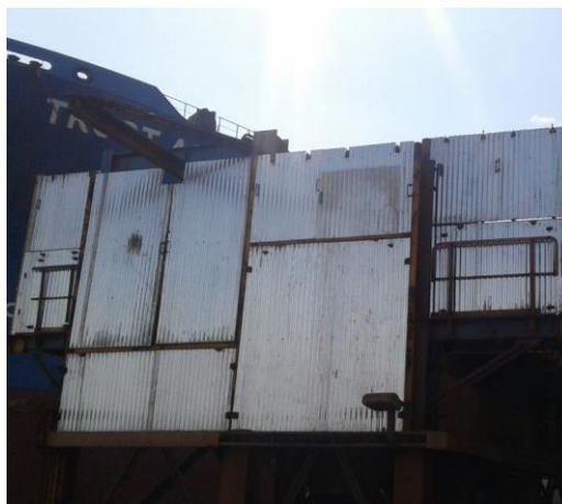
Enclausuramento das casas de transferência dos transportadores do Píer 1.
