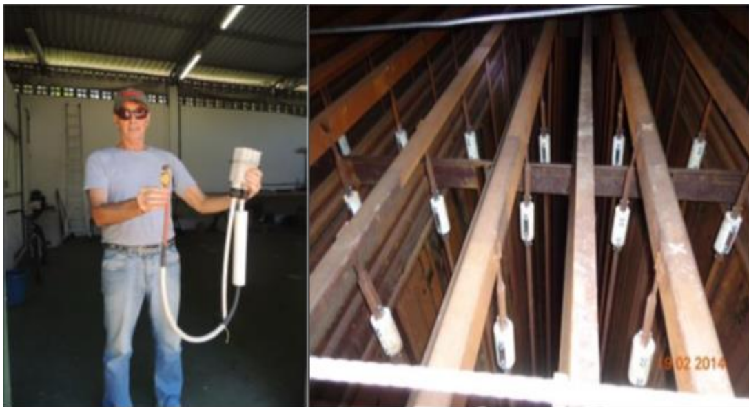
Projeto piloto sendo implantando no PE 04 da Usina 8, para avaliação em escala real da performance dos equipamentos e eficiência de redução de poeira.
