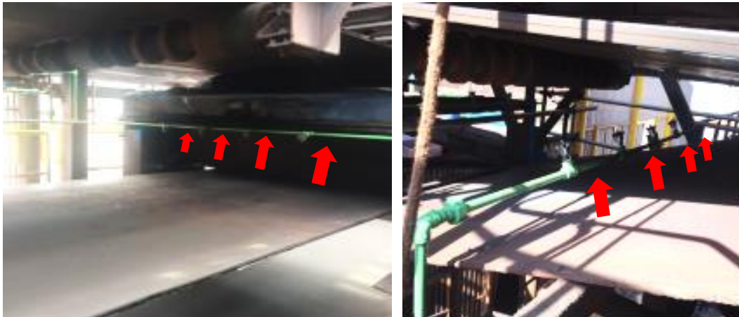
Exemplos de aspersores de névoa sobre e sob correia (bicos apontados pelas setas).
