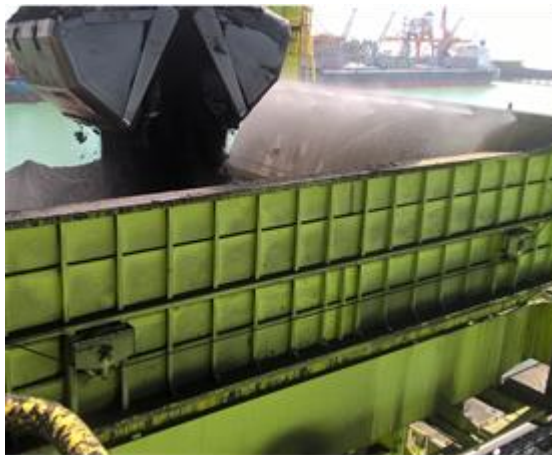
Aspersão da moega do DN7 em atividade.
