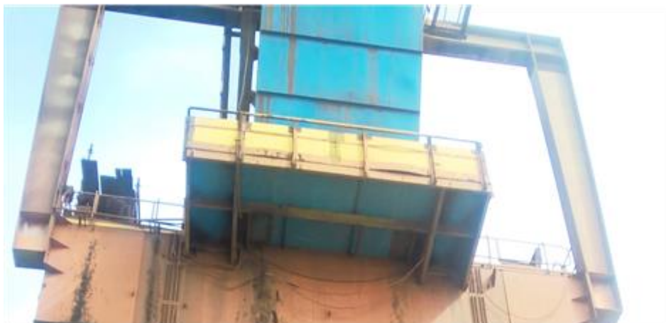
Varanda e calha de contenção na traseira dos CNs do píer 2.
