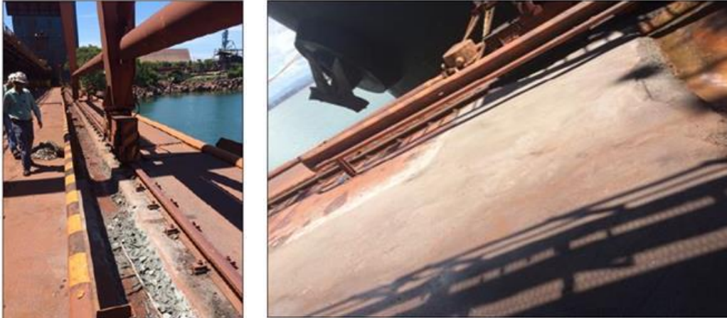
Obras de melhoria da drenagem e nivelamento do piso do píer 1.
