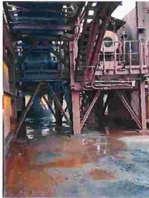
Figura 46 – Aspersão de água na correia transportadora de minério do Píer 1
