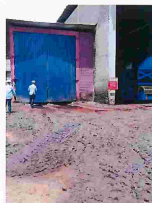
Figura 65 – Depósito intermediário de resíduos de fertilizantes em via sem pavimentação
