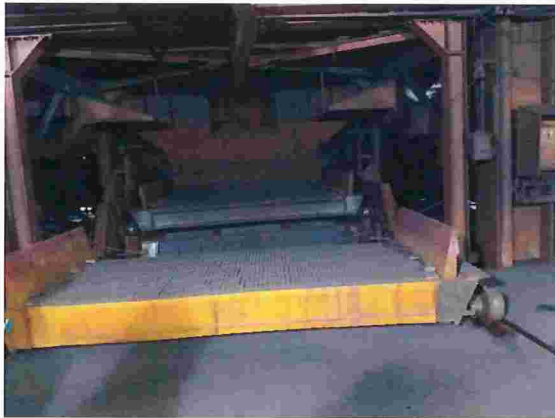
Figura 13 – Entrada do forno com forração das grelhas com pelotas já queimadas
