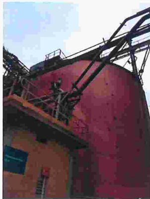
Figura 9 – Tanque de homogeneização (polpa de minério + polpa de carvão antracito)
