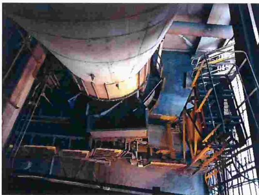
Figura 33 – Entrada de minério no moinho
