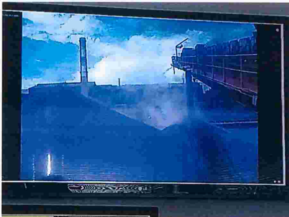
Figura 3 – Chaminé com monitor contínuo
