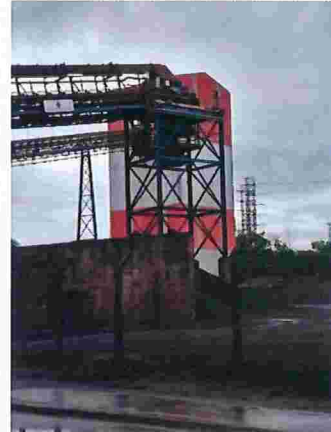
Figura 29 – Pátio de emergência de pelotas já queimadas
