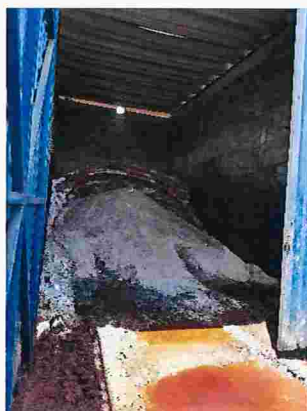
Figura 64 – Interior do depósito intermediário de resíduos (DIR)
