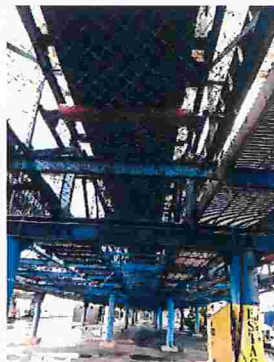
Figura 70 – Correia transportadora sem bandejamento e sem contenção lateral
