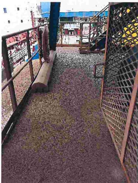
Figura 56 – Depósito de material no descarregador de navio
