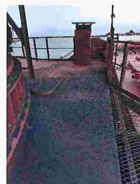
Figura 51 – Depósito de minério (pellet feed) no carregador de navios durante operação da lança
