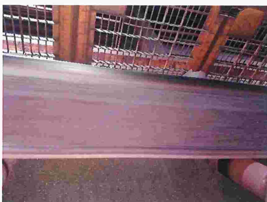
Figura 17 – Detalhamento de esteiras sem bandejamento inferior com acúmulo de pó no chão e sem contenção lateral, próximo a entrada do forno da Usina 3.
