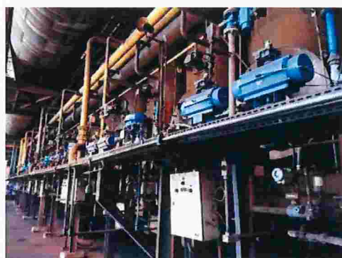
Figura 184 – Detalhe da lateral do forno da área de queima
