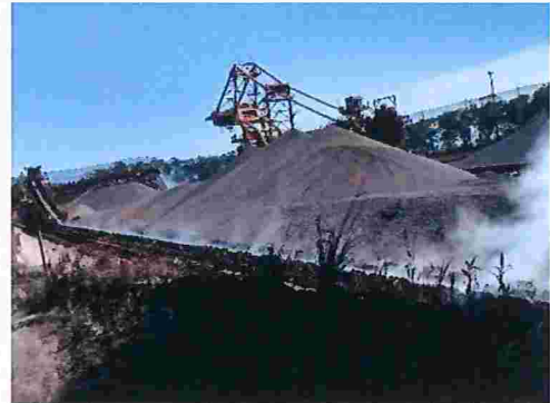
Figura 100 – Emissão de vapor das correias transportadoras
