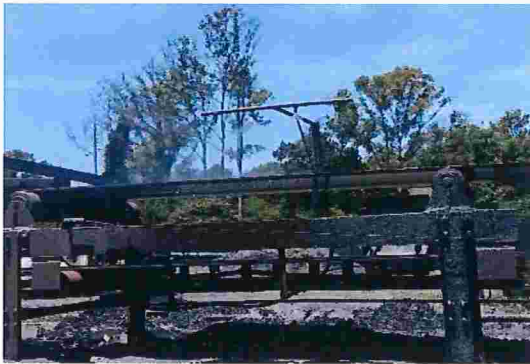
Figura 89 – Umectação na entrada da correia transportadora (Pátio M)
