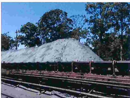
Figura 95 – Detalhe da correia transportadora
