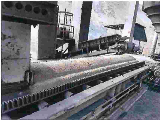
Figura 151 – Depósito de particulado no interior da unidade de silo e dosagem de materiais
