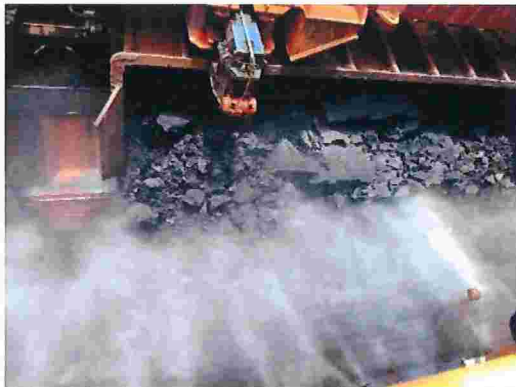
Figura 73 – Aspersão dos vagões no virador
