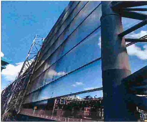
Figura 1 – Pátio de carvão provido de Wind fence
