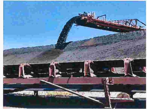
Figura 26 – Detalhe da formação de pilhas com projeção de material
