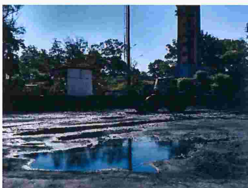
Figura 41 – Pátio de carvão (Unidade de Moagem)
