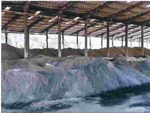
Figura 145 – Interior do galpão de armazenamento de materiais
