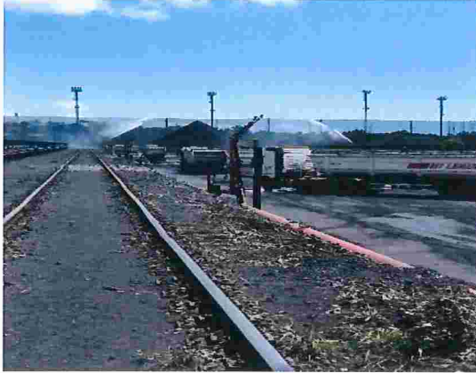
Figura 11 – Detalhe da aspersão de água no pátio com canhões
