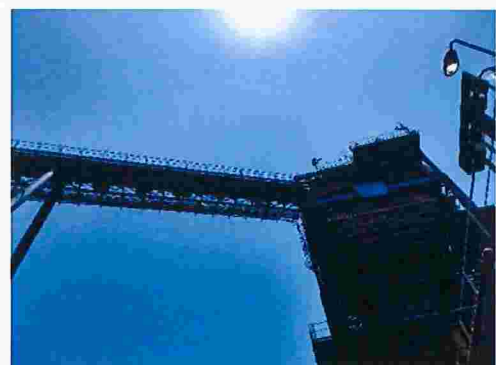
Figura 16 – Detalhe da entrada da correia transportadora no silo de carvão
