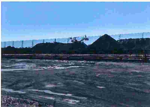
Figura 13 – Detalhe da correia transportadora sem cobertura superior, bandejamento e contenção lateral
