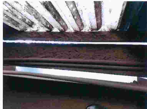
Figura 64 – Detalhe de material depositado junto à parede de enclausuramento
