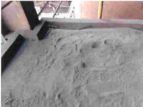
Figura 173 – Acúmulo de material no piso
