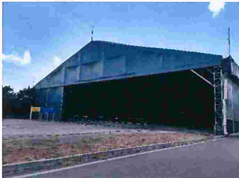
Figura 165 – Armazenamento de calcário sem anteparos na entrada
