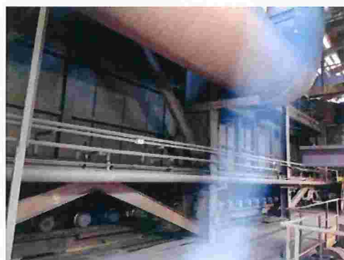
Figura 182 – Detalhe do forno com lateral aberta
