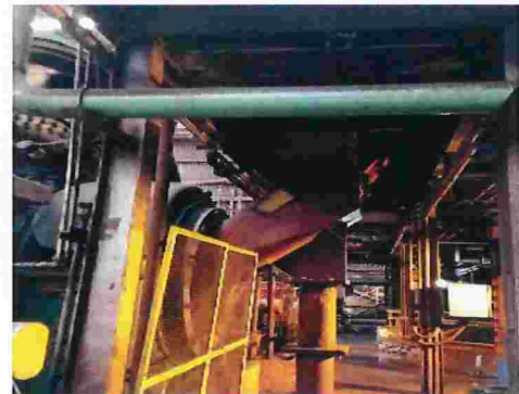
Figura 170 – Entrada de água no moinho
