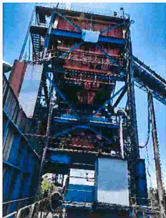
Figura 17 – Silo de carvão para carregamento de vagões
