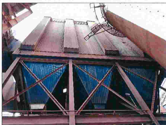
Figura 119 – Detalhe da estrutura do precipitador eletrostático sem identificação
