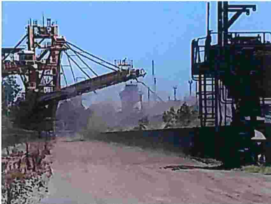
Figura 83 – Emissão fugitiva dentro dos pátios
