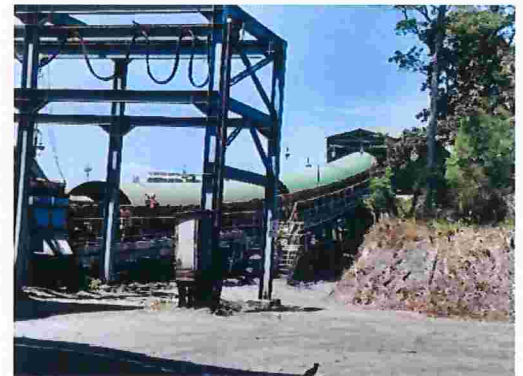
Figura 90 – Correia transportadora com cobertura (Pátio M)
