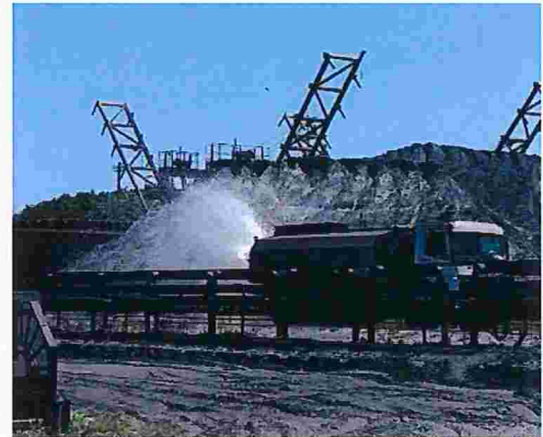
Figura 84 – Aspersão de água por caminhão pipa nas vias dos pátios
