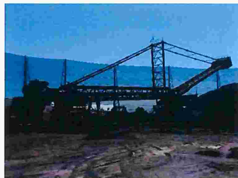
Figura 34 – Detalhe da recuperadora de pilhas
