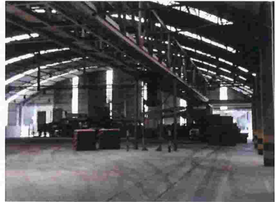
Figura 158 – Área de expedição com depósito de particulado no piso
