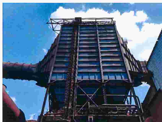
Figura 120 – Detalhe da estrutura do precipitador eletrostático sem identificação
