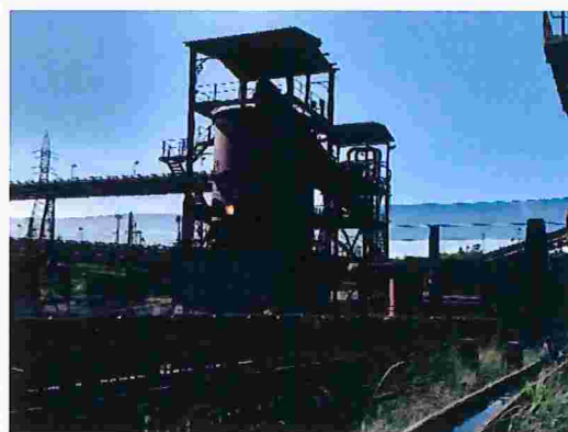
Figura 106 – Silo de cal
