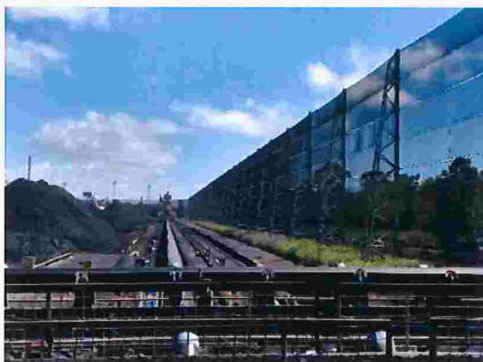
Figura 9 – Wind fence nas laterais do pátio
