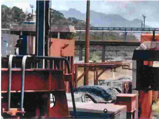
Figura 71 – Aspersão do vagão de sinter feed antes do basculamento no virador de vagões
