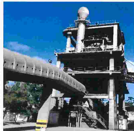
Figura 152 – Detalhe de correia transportadora provida de cobertura e contenção lateral
