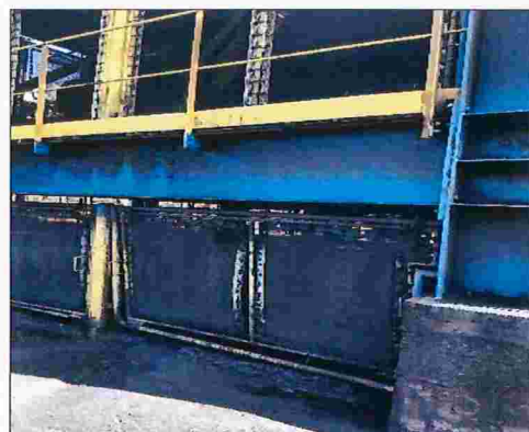
Figura 4 – Depósito de material no solo
