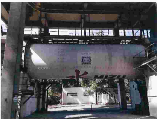
Figura 153 – Moinho de cimento
