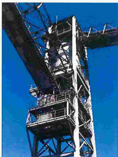
Figura 98 – As correias tem bandejamento e cobertura superior, mas não tem contenção lateral
