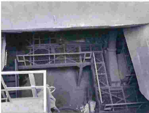
Figura 45 – Detalhe de material depositado no solo das correias transportadoras subterrâneas
