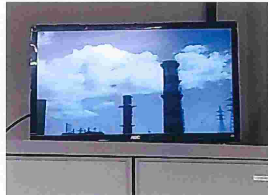
Figura 52 – Sala de controle com detalhe de monitoramento das emissões das caldeiras por imagem (analísadores NO x , SO 2 , CO e opacidade)
