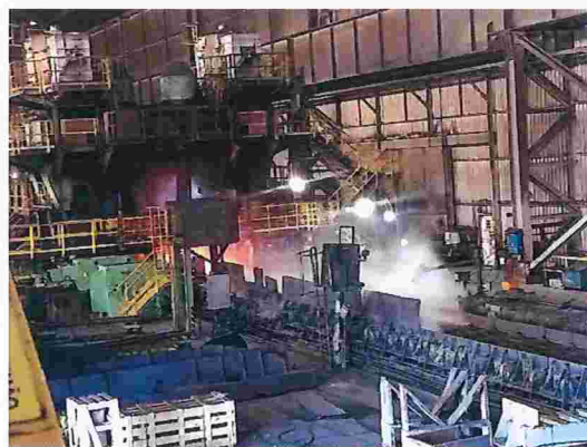
Figura 66 – Detalhe da descarepação primária com emissão de vapor
