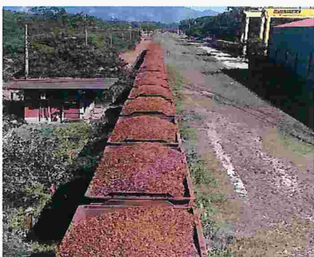
Figura 124 – Material que já chega úmido no virador de vagões
