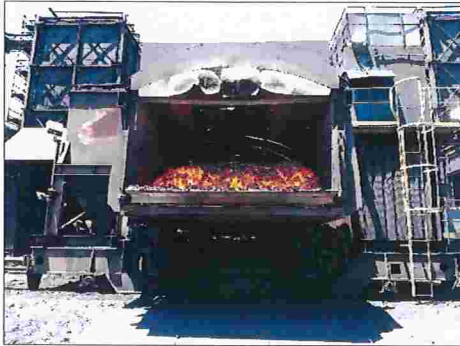
Figura 90 – Detalhe do ciclone na lateral do hot car
