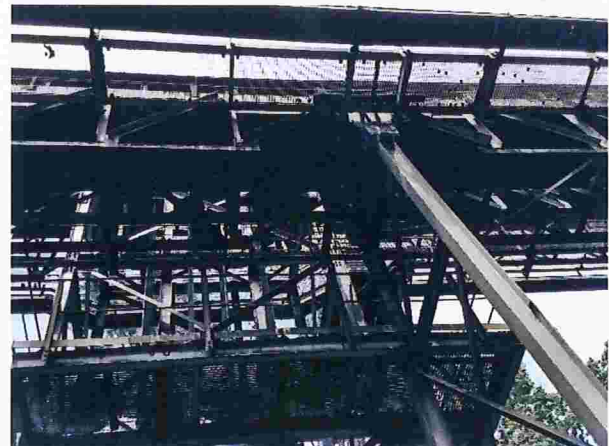
Figura 22 – Detalhe da abertura na grade inferior da correia
