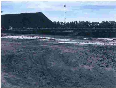
Figura 11 – Pátios de carvão com pilhas sem identificação e correia transportadora com acúmulo de material na lateral
