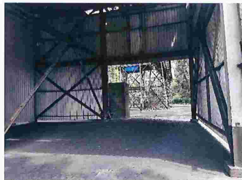
Figura 18 – Detalhe do chute que estava em reparo
