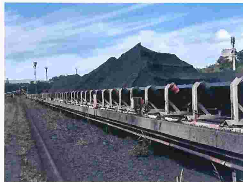
Figura 12 – Correia transportadora a céu aberto sem cobertura superior devido ao tripper
