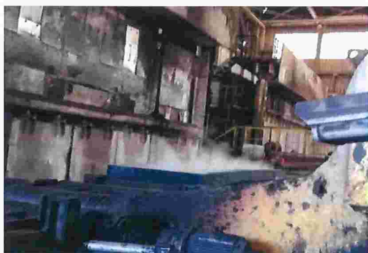
Figura 71 – Detalhe da operação de enfornamento das placas sem emissão visível
