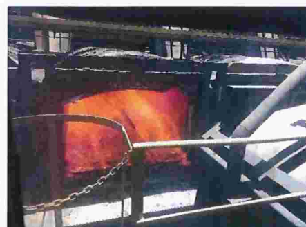
Figura 89 – Emissão fugitiva após retirada do coque do forno (porta aberta sem captação)
