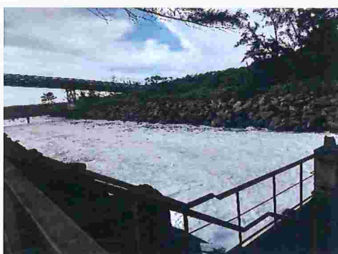
Figura 1 – Canal de acesso marítimo
