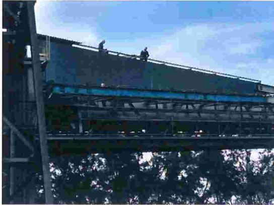
Figura 19 – Detalhe do reparo em execução da cobertura superior da correia transportadora de coque para o alto forno 3
