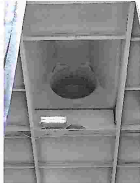
Figura 43 – Detalhe da captação na parte superior do silo térreo
