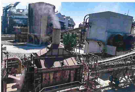
Figura 138 – Resfriador da granulação de escória com emissão visível
