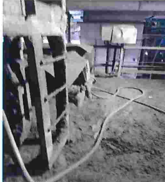
Figura 132 – Pó depositado no piso e nas estruturas
