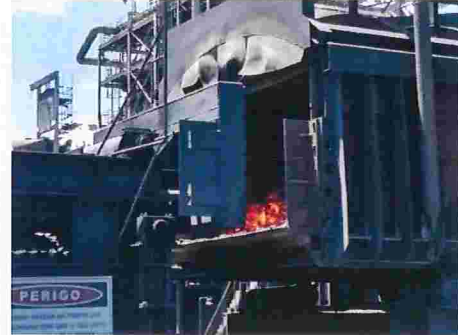
Figura 91 – Descarregado de coque na torre de apagamento com emissão fugitiva, embora com aspersão de água na extremidade
