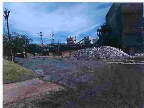
Figura 48 – Materiais armazenados em baias a céu aberto, sem identificação.
