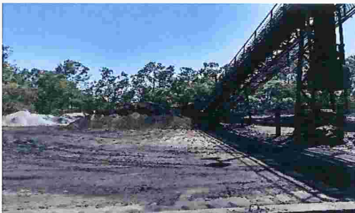
Figura 158 – Correia transportadora de materiais para o silo sem bandejamento, sem contenção lateral e sem cobertura.
