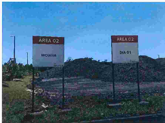
Figura 57 – Identificação de materiais sem delimitação física dos mesmos
