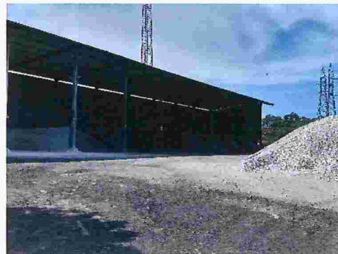
Figura 46 – Armazenamento de materiais em baias em galpão, sem identificação.
