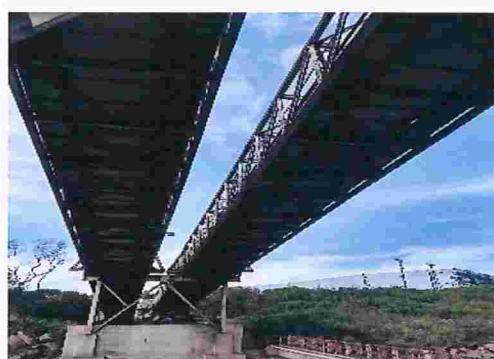
Figura 2 – Correia transportadora de carvão com bandejamento sobre o canal
