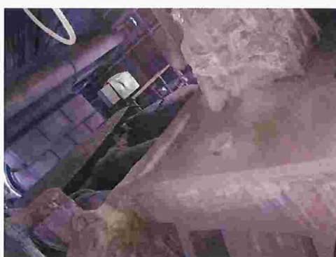
Figura 131 – Pó depositado nos equipamentos de processo
