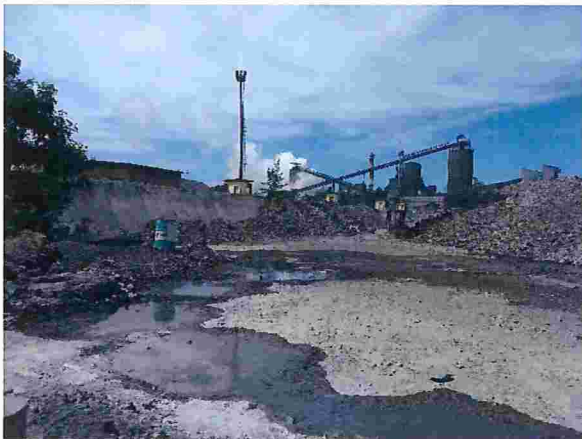
Figura 37 – Pilhas de materiais armazenadas no pátio da HARSCO, sem identificação permanente.
