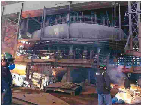
Figura 134 – Emissão visível do vazamento furo de gusa
