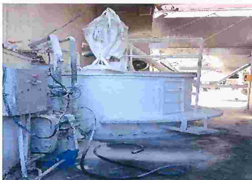
Figura 152 – Preparação da cal para aplicação nos moldes
