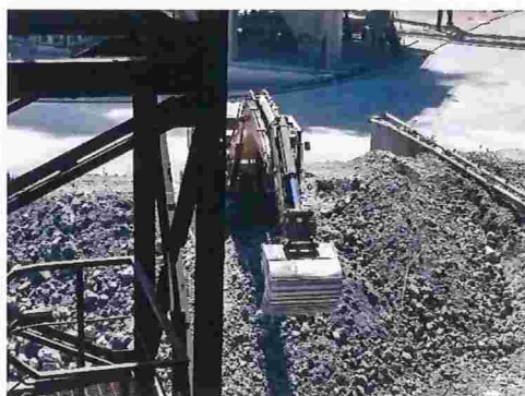
Figura 139 – Detalhe da operação de tratamento de escória no dry pit
