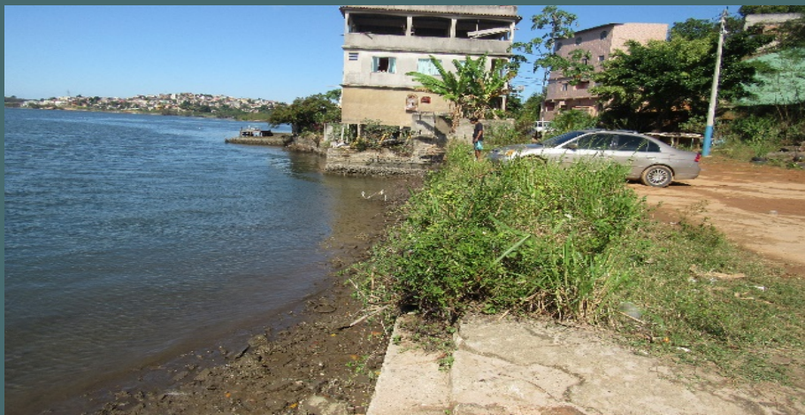
Estação Porto de Santana
