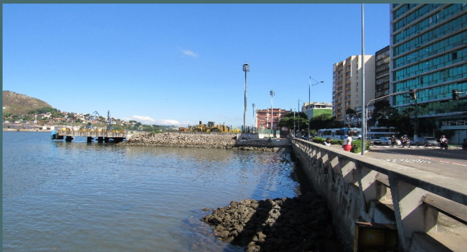
Estação Porto de Vitória
