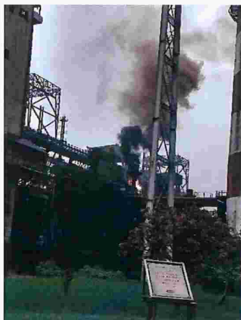
Figura 10 – Problema operacional nas baterias de fornos da coqueria com emissão de gases para a atmosfera
