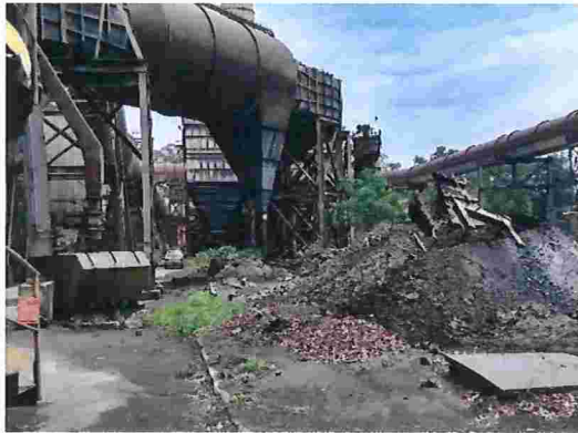
Figura 57 – Resíduos depositados no solo na área de processo da aciaria
