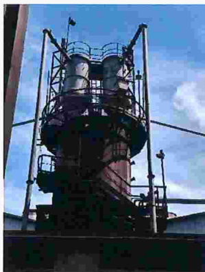
Figuras 47, 48 e 49 – Detalhe do sistema de captação de lançamento por chaminés das casas de corrida 1 e 2 do Alto forno 3
