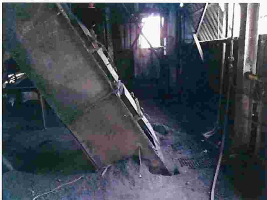
Figura 8 – Carvão depositado nos chutes
