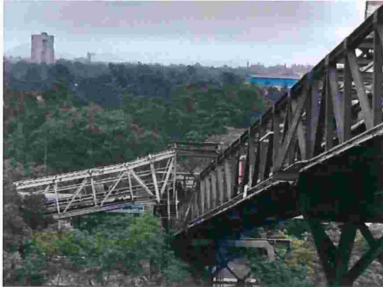
Figura 2 – Chute e correias transportadoras sem enclausuramento para silo de carvão
