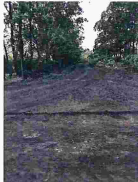
Figura 97 – Vias de acesso sem pavimentação com material depositado
