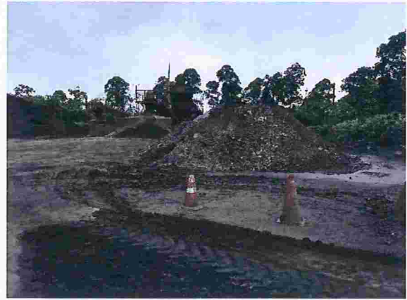
Figura 96 – Pátio com beneficiamento (peneiramento) de materiais
