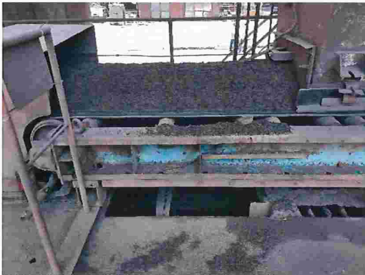
Figuras 92 – Correia sem contenção e depósito de materiais no piso da área de silos
