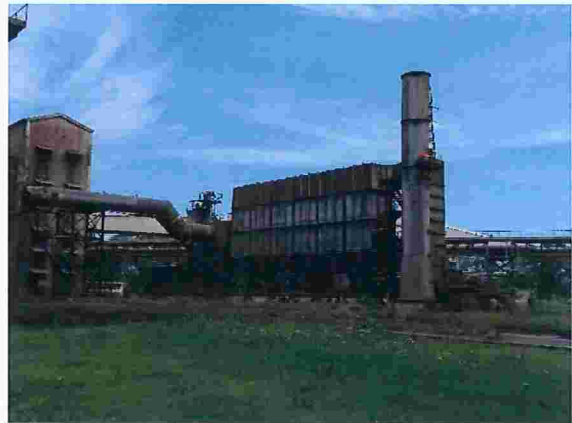
Figura 60 – Detalhe de um dos sistemas de despoeiramento da descarga do ferro gusa dos carros-torpedo
