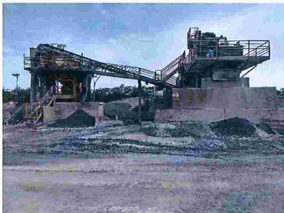
Figura 99 – Pátio com beneficiamento (peneiramento) de materiais
