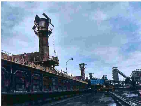
Figura 22 – Detalhe da bateria de fornos da coqueria heat recovery (damper aberto)
