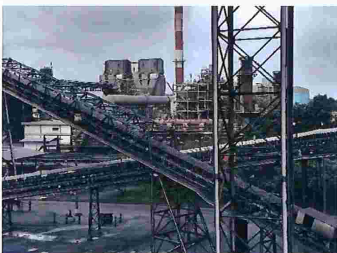
Figura 32 – Detalhe geral das correias transportadoras de carvão e do material depositado no solo
