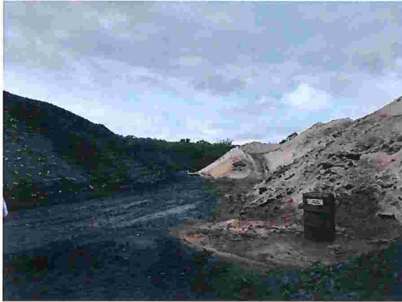
Figura 95 – Pátio com pilhas diversas e pilha de pó de alto forno com plantação de leguminosas
