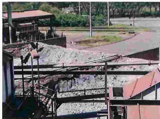
Figura 46 – Detalhe do dry pit para tratamento de escória a céu aberto
