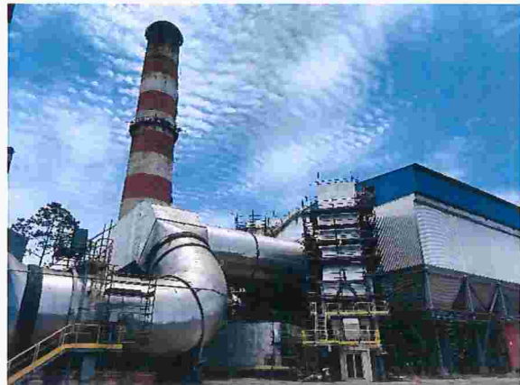
Figura 93 – Detalhe da construção do by-pass do novo filtro de mangas
