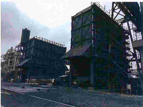
Figura 36 – Coque desenfornado dentro da torre de apagamento
