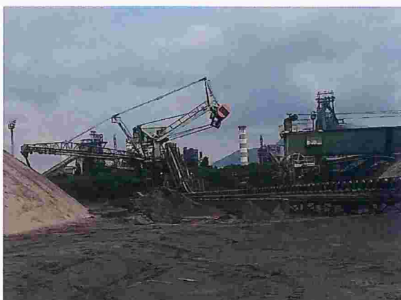
Figura 76 – Detalhe da máquina blend reclaimer
