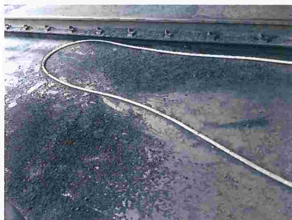
Figura 14 – Depósito de material no topo da bateria de fornos da Coqueria
